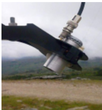
(fig. 10) guíaonda transmisor iluminando la parábola
